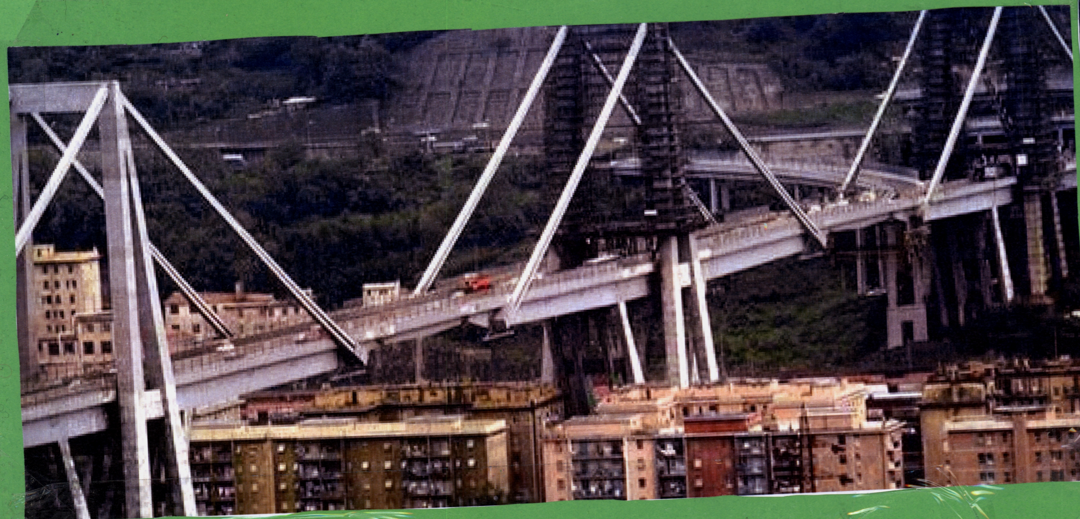
Il ponte Morandi ancora in piedi e per fortuna non è ancora crollato ma era previsto che sarebbe crollato dalla tempesta che c'era il 14 agosto.
